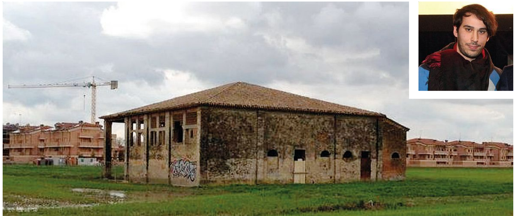
Villetta a schiera in costruzione «assediano» un vecchio fienile nella periferia est della città di Ferrara. Nella foto piccola, Giuseppe Muroi
