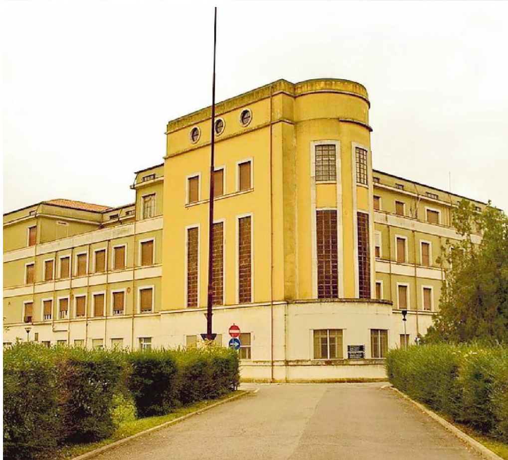
In alto una foto scattata nella colonia post sanatoriale di Tresigallo nel 1943, sopra l'edificio in anni recenti
