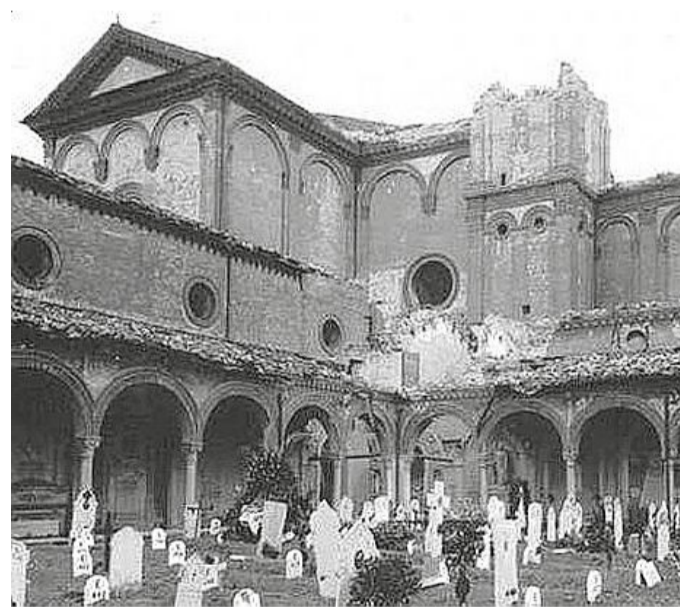
L'edificio e il campanile della Certosa di Ferrara, danneggiati
