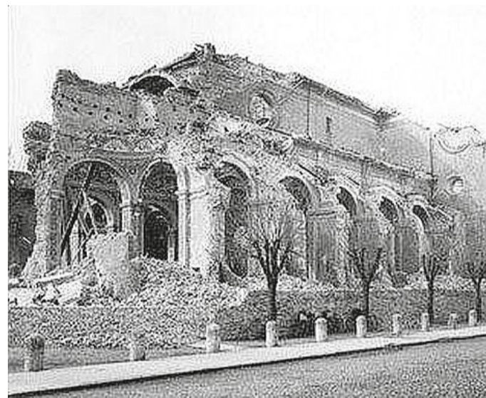
Il fianco distrutto della stessa chiesa cittadina
